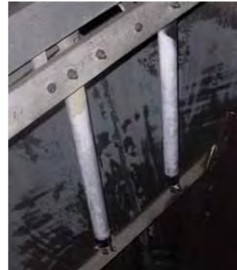
Instalación de sensores de humedad
