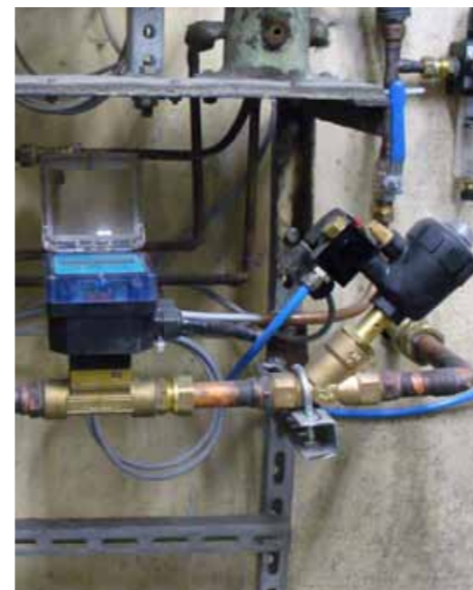
Construcción de medición de agua
