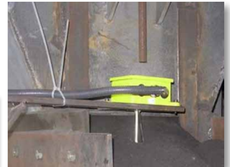
Instalación de sensores de temperatura
